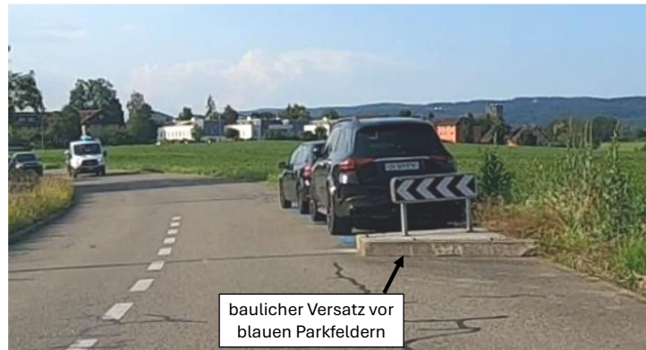
Abbildung 22: Beispiel baulicher Versatz bei Parkfeld entlang Schwerzelbodenstrasse in Dietlikon
