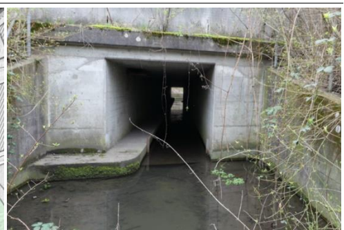
Abbildung 4: Oberes Ende des Durchlasses Bra-01, Blick in Fliessrichtung (eigene Aufnahme)
