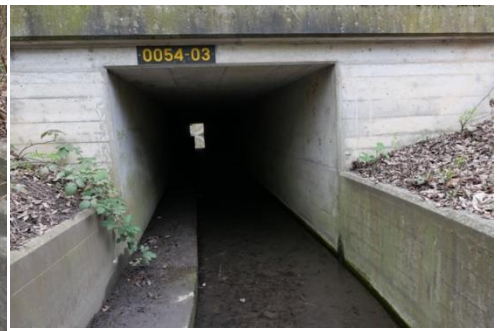
Abbildung 6: Oberes Ende des Durchlasses Bra-03, Blick in Fliessrichtung (eigene Aufnahme)
