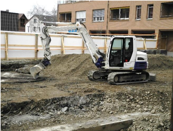
Wo im Frühling 2014 der Bagger stand, ....
