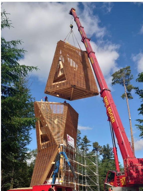
Die Holzelemente werden mit einem Spezialkran montiert (Bild: Ph. Flach)
