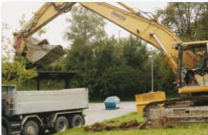
Spatenstich neues Betriebsgebäude
