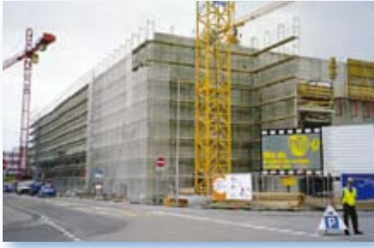
Baustelle Multiplexkino im Industriegebiet
