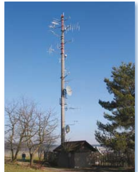
Radio- und Fernsehempfangsanlage im Klimm
