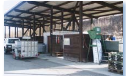
Zentrale Wertstoffsammelstelle Hofwiesen
