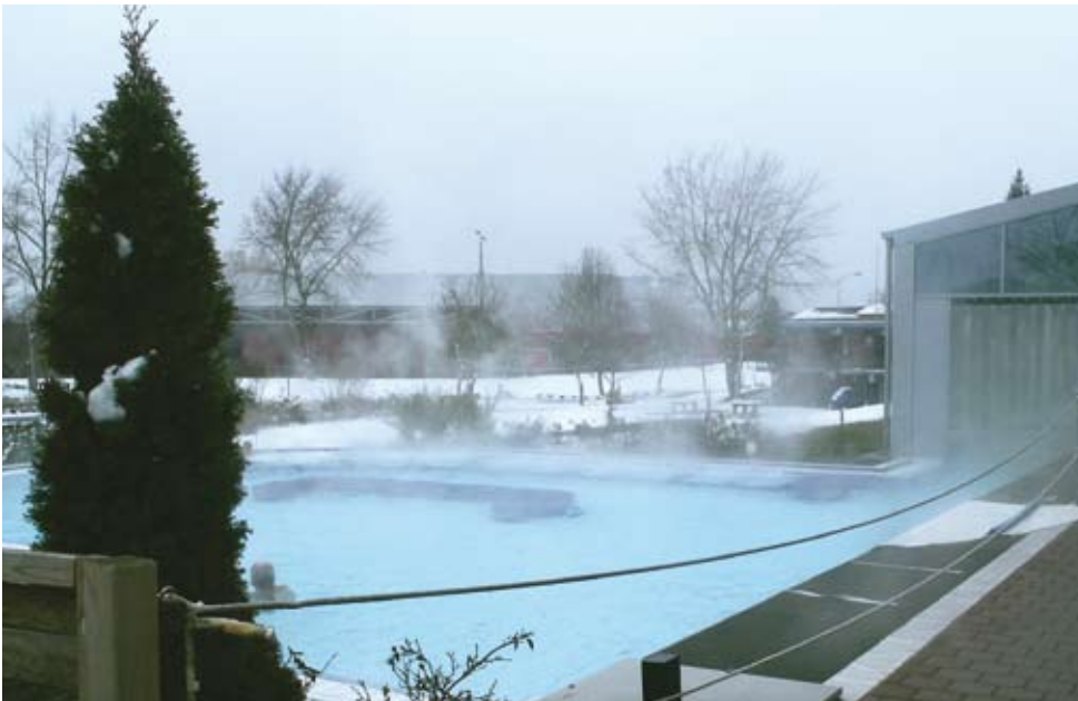
Blick auf das beheizte Aussenbecken mit Sprudelanlage
