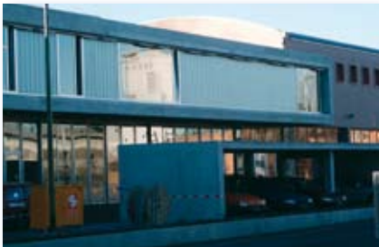
Das neue Betriebsgebäude kurz vor der Fertigstellung
