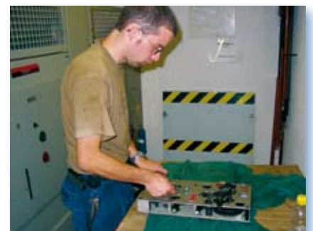
Sven Holliger bei der Revision eines 16 kV Schalteraufzugs
