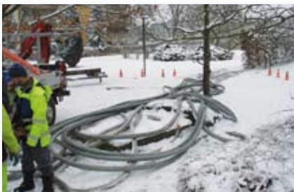
Defektes 16-kV Kabel wird durch Werkangehörige ausgewechselt
