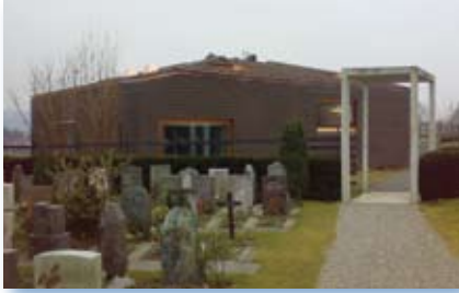
Aufbauungsgebäude nach der Sanierung
