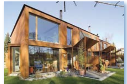
Neubau von einem DEFH und einem 3er-REFH an der Steinackerstrasse des Architekten Peter Dammann (Musterhaus)
