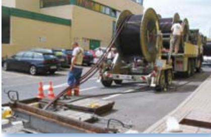
Kabeleinzug durch die EKZ
