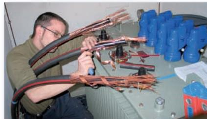
Anschluss eines Transformators
