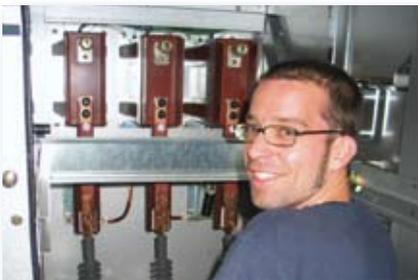
Sven Holliger in einer Mittelspannungszelle beim Anschliessen von Kabelendverschlüssen.
