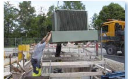
Einbringen eines Transformators in die neue Transformatorstation Aegertstrasse 11
