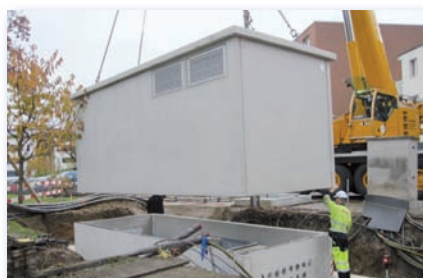
Transformatorstation im Bau
