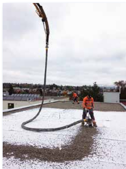
Flachdach Schulhaus Hüenerweid
