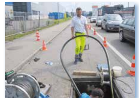
Niederspannungskabelzug für TESLA Supercharger-Tankstelle
