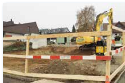
Neubau EFH Rebweg 1
