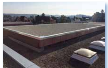
Flachdach Schulhaus Hüenerweid
