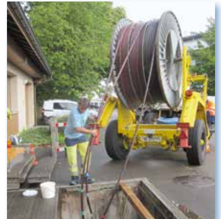
Einzug Mittelspannungskabel
