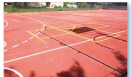
Roter Platz nach Sanierung
