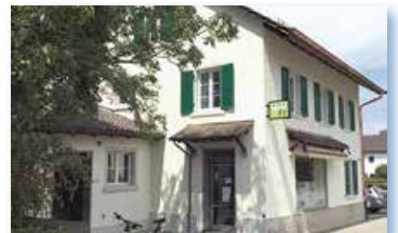
Milchhüslis nach Oberflächensanierung
