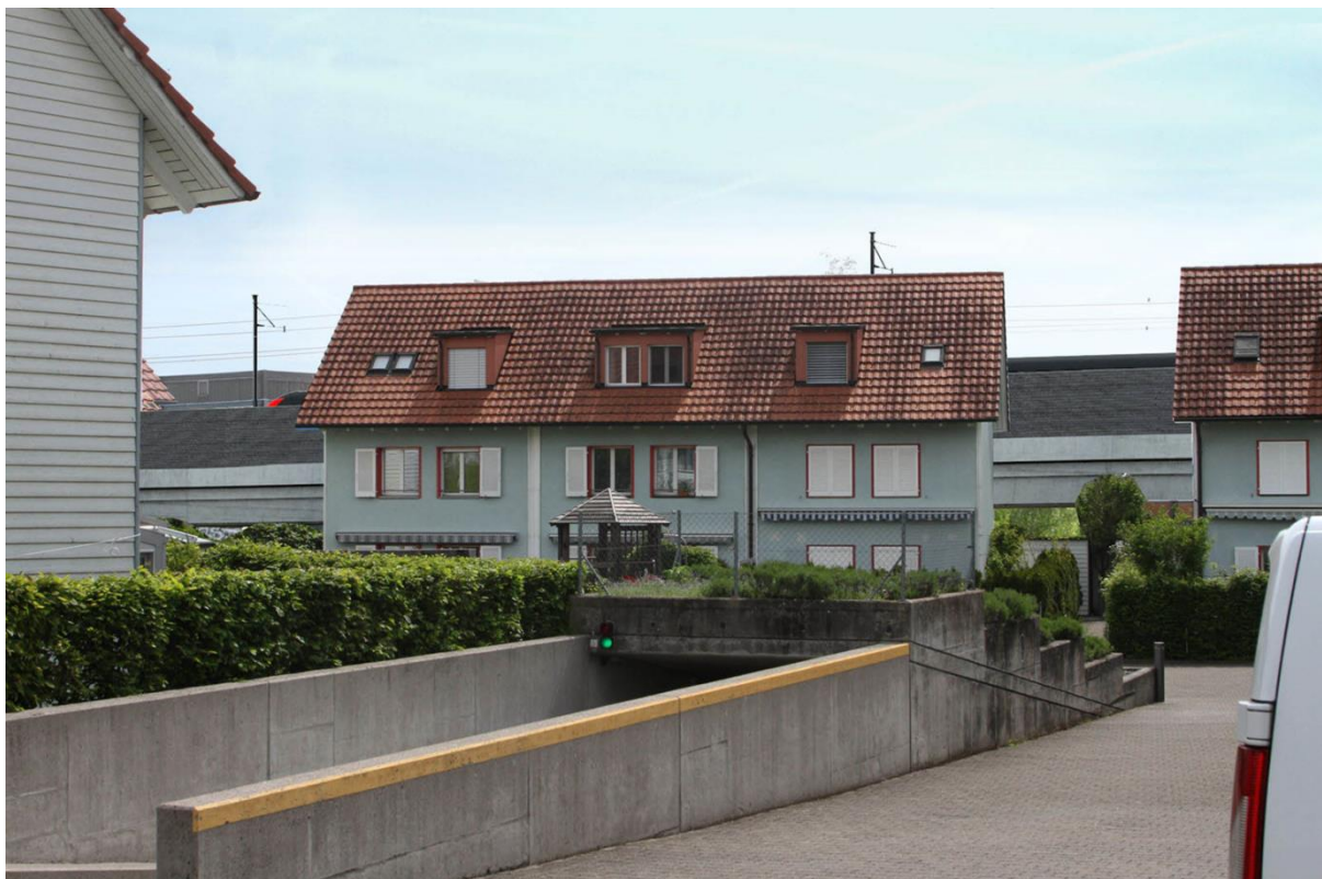
Legende: Ansicht vom Wohnquartier "In Lampitzäckern" auf die neue Eisenbahn-Betonbrücke
