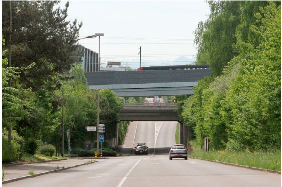
Visualisierung der Brücke an der Bahnhofstrasse. (Quelle: STUDIO TRIXER Hofmänner & Fielitz, Zürich, im Auftrag der Gemeinde Dietlikon)
