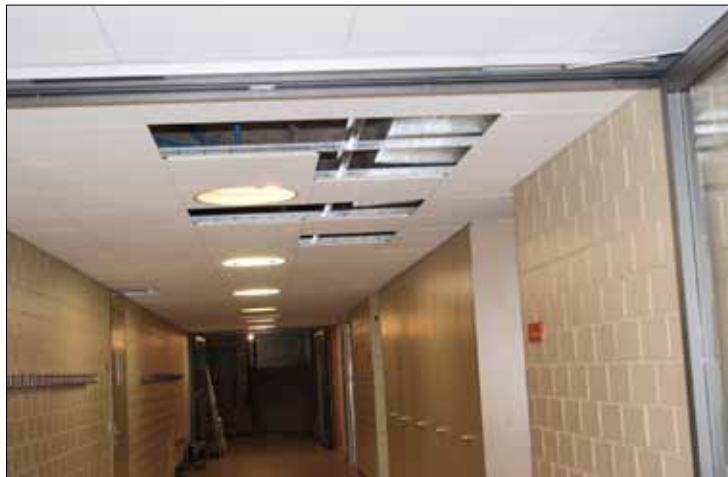
Die Deckenplatten werden mutwillig mit Bällen oder anderen Gegenständen beschossen und fallen zu Boden.
